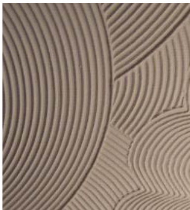
Создается с помощью разных шпателей для плиточного клея с разной шириной хода
